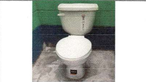
FOTO 6: SUSTITUCION DE INODORO.
